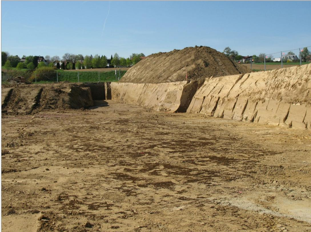
Abb. 2.2.3.7.: Baugrube in Leonding, Erweiterung Sparfiliale Nußböckstraße: 3,5m strukturloser Löss-Lehm an der Nordostwand der Baugrube (Foto: Ch. Rupp).
