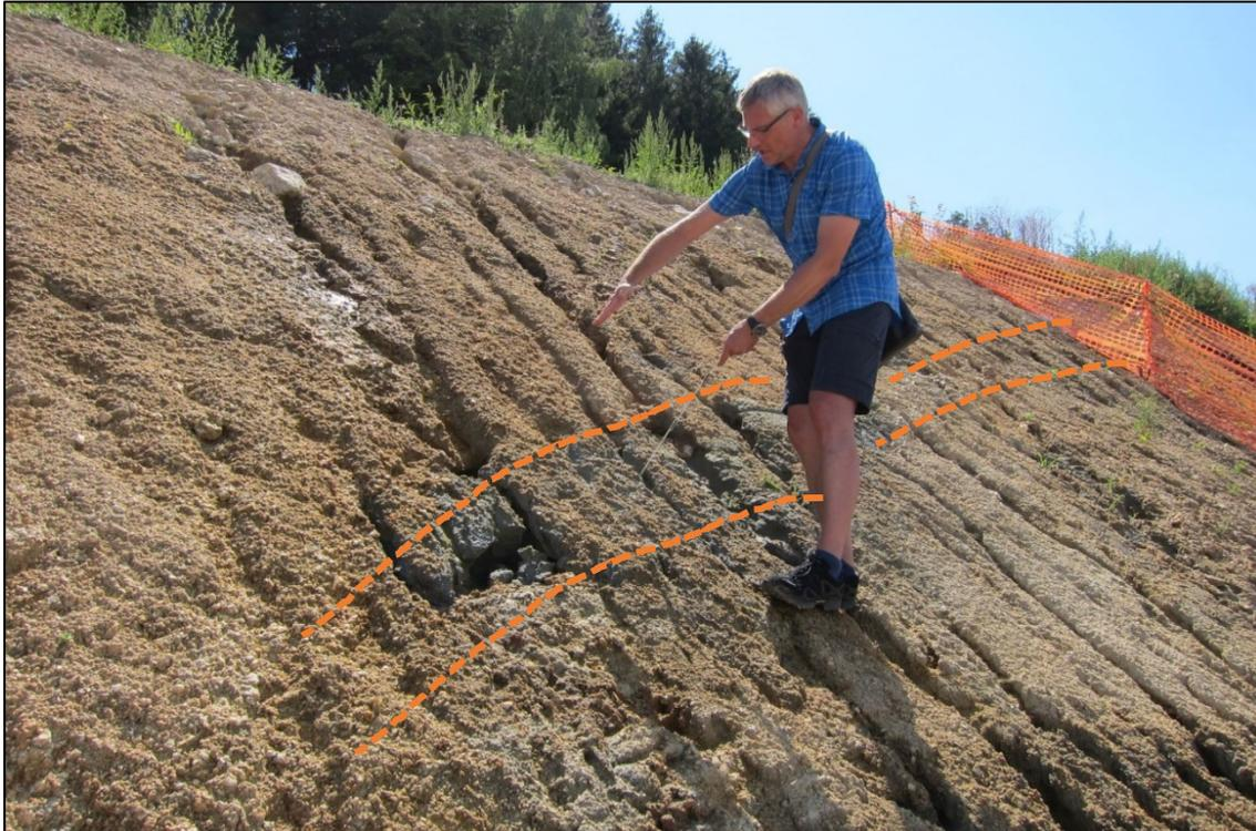
Abb. 2.1.1.11.: Hanganschnitt Baustelle Altenberg bei Linz: Über den gesamten Aufschluss war eine NE/SW streichende Störungszone in Form einer ca. 25 cm mächtigen, dunkelgrauen Kataklysezone erkennbar (Foto: M. Peresson).
