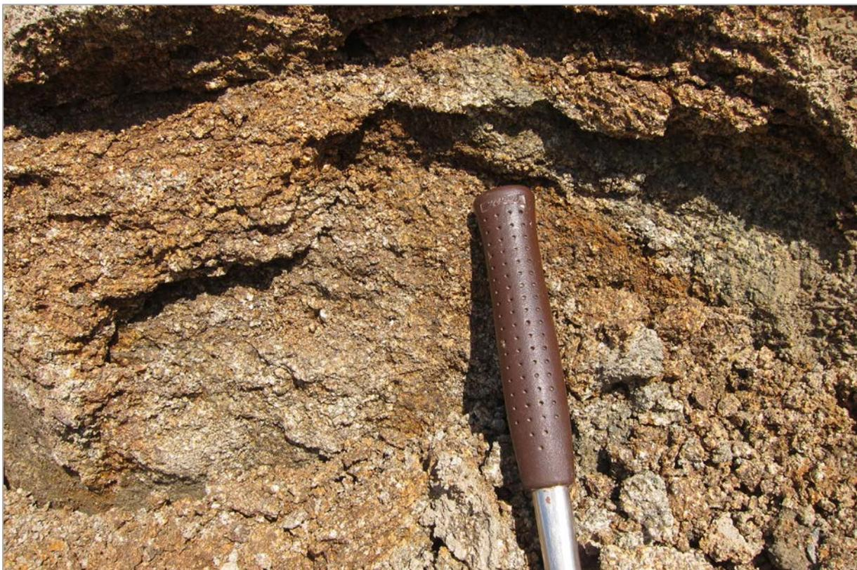
Abb. 2.1.2.11.: Business Campus ONE in Hagenberg: stark vergruster Freistädter Granodiorit in der Baugrube; Korngefüge weitgehend aufgelöst (Foto: M. Peresson).
