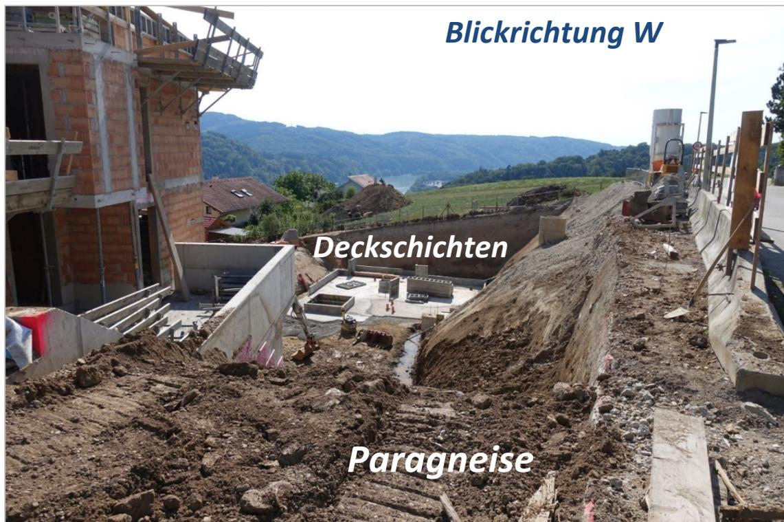
Abb. 2.1.3.8.: Baugrube am Reisingerweg in Linz, Pöstlingberg: Hanganschnitte an der West- und Nordseite der Baugrube gekennzeichnet durch Paragneise und ockerbraune Deckschichten im Hangenden (Foto: M. Peresson).
