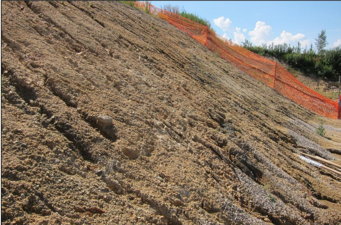
Abb. 2.1.1.9.: Hanganschnitt Baustelle Altenberg bei Linz: Überwiegend vollständig verwitterter Altenberger Granit (Flinz); vereinzelt unverwitterte Bereiche im Gesteine mit erkennbaren Hauptgemengteilen zu beobachten (Foto: M. Peresson).
