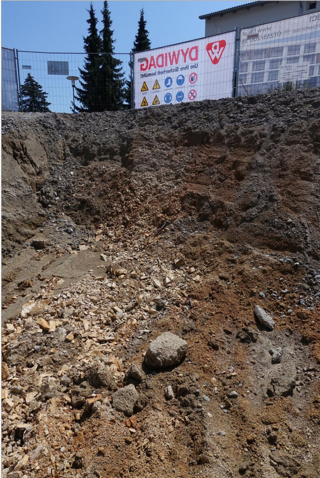
Abb. 2.1.2.15.: Business Campus ONE in Hagenberg: stark zerscherscherter heller Aplitgang im Süden der Baugrube (Foto: M. Peresson).
