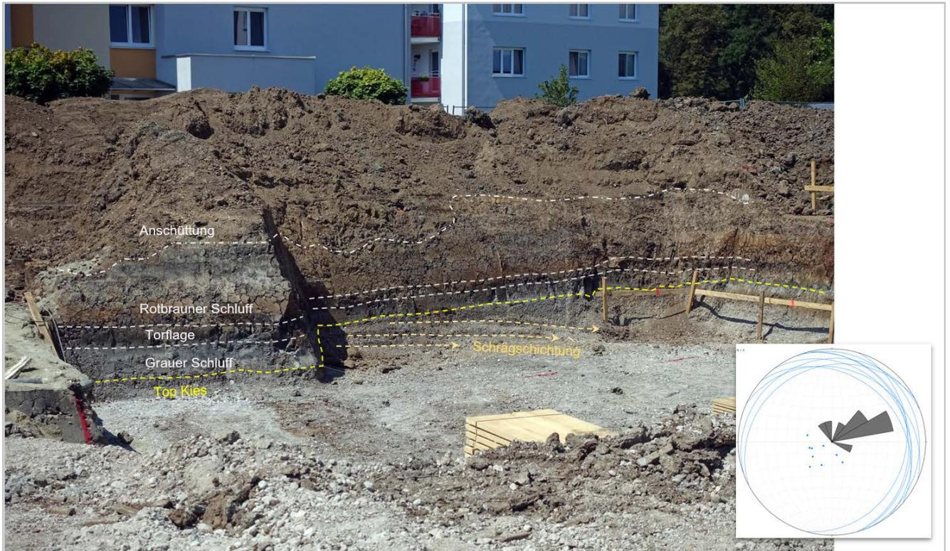
Abb. 2.3.1.19.: Aufschlusswand in Baumgartenberg; Überblicksaufnahme; Einregelung der Kiese erkennbar (Foto: M. Peresson).
