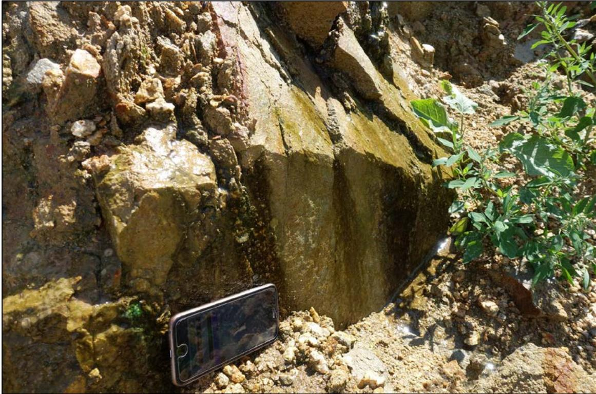
Abb. 2.1.1.18.: Hanganschnitt Baustelle Altenberg bei Linz: Deutlich ausgeprägte Kluftbildungen im Bereich der Scherzone (Foto: M. Peresson).
