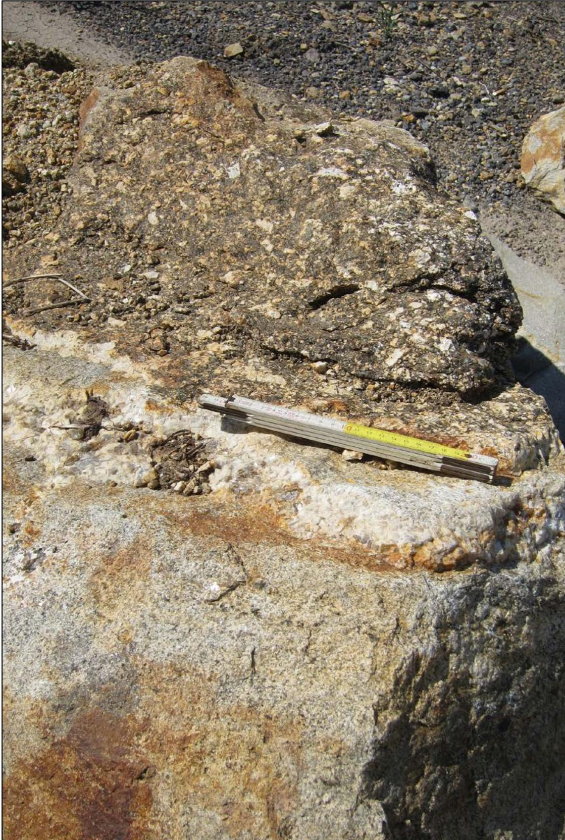
Abb. 2.1.1.21.: Hanganschnitt Baustelle Altenberg bei Linz: Im östlichen Teil des Bauplatzes konnte der Übergang von grobkörnigem Weinsberger Granit zu feinkörnigem Altenberger Granit beobachtet werden (Foto: M. Peresson).
