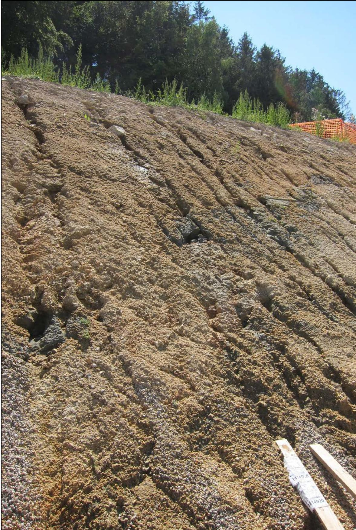
Abb. 2.1.1.10.: Hanganschnitt Baustelle Altenberg bei Linz: Vollständig verwitterter Altenberger Granit (Flinz) (Foto: M. Peresson).
