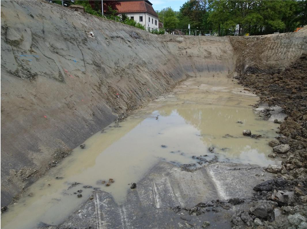
Abb. 2.2.1.10.: Baustellengelände der Johannes-Kepler-Universität in Linz: Hanganschnitt an der Ostseite und der Südseite; „Älteren Schlier“ an der Basis und blaugrauen Hochflutsedimenten im Hangenden (Foto: F. Hofmayer).
