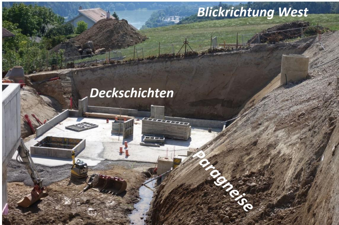
Abb. 2.1.3.9.: Baugrube am Reisingerweg in Linz, Pöstlingberg: An der Nordseite der Baugrube erstrecken sich die Paragneise bis an die Geländeoberkante; an der Westseite sind über geringmächtigem Kristallin ockerbraune Deckschichten zu erkennen (Foto: M. Peresson).
