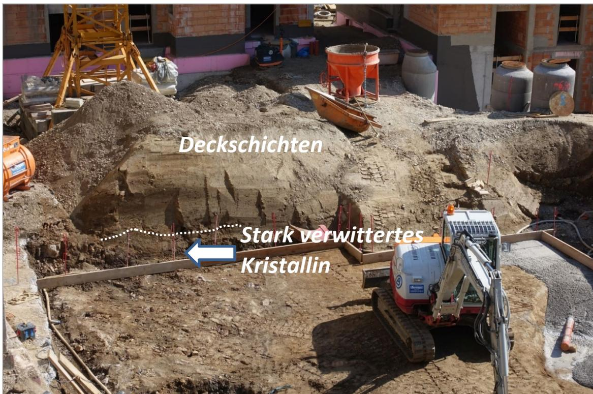
Abb. 2.1.3.14.: Baugrube am Reisingerweg in Linz, Pöstlingberg: Südseite - strukturlose Deckschichten im Hangenden; an der Basis Aufarbeitungshorizont aus stark verwittertem Kristallin (Foto: M. Peresson).
