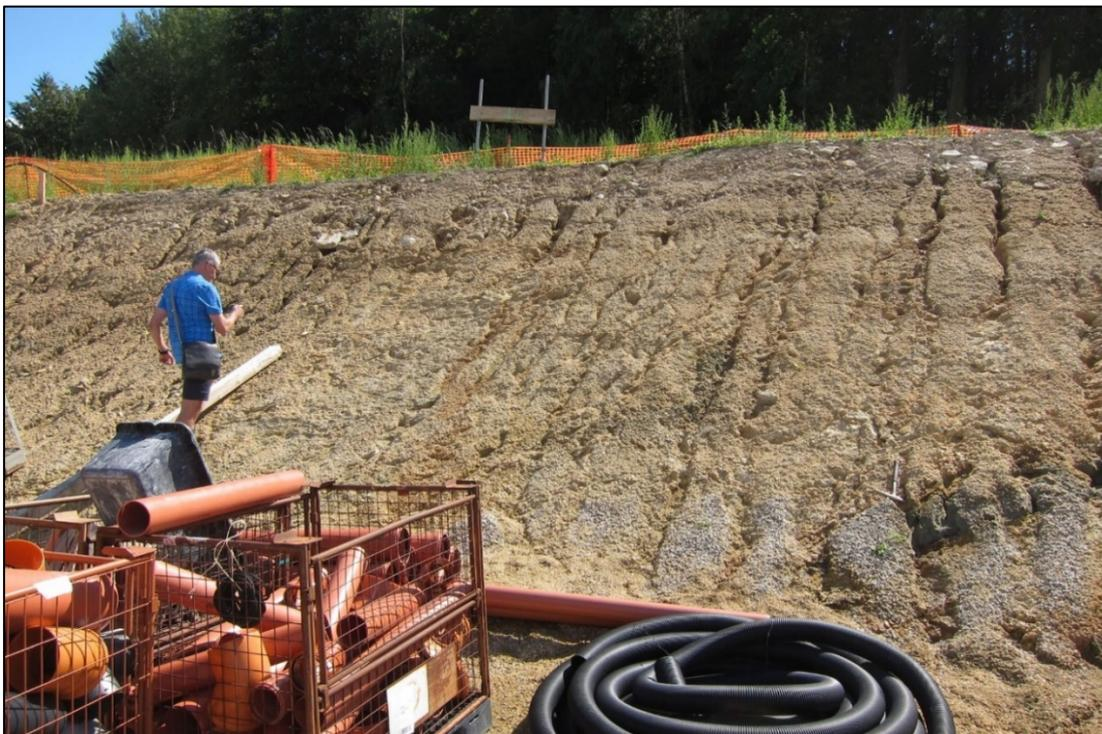
Abb. 2.1.1.12.: Hanganschnitt Baustelle Altenberg bei Linz: Vollständig verwitterter Altenberger Granit (Flinz); im Hangenden vermehrt Hangschutt aus unverwitterten Blöcken von Altenberger Granit (Foto: M. Peresson).
