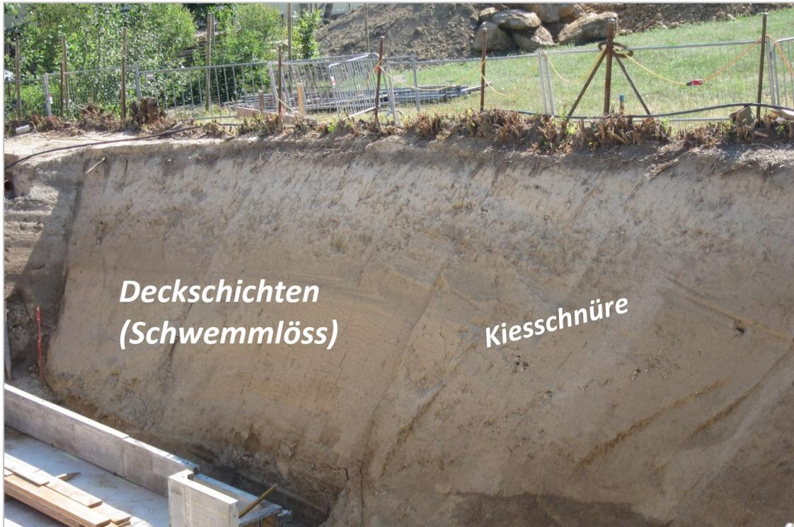
Abb. 2.1.3.11.: Baugrube am Reisingerweg in Linz, Pöstlingberg: Westseite gekennzeichnet durch strukturlose Deckschichten („Schwemmlöss“) mit Einlagerung von Kiesschnüren (Foto: M. Peresson).
