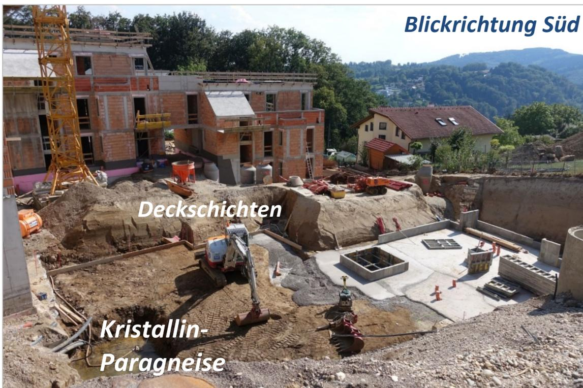
Abb. 2.1.3.12.: Baugrube am Reisingerweg in Linz, Pöstlingberg: Südseite gekennzeichnet durch strukturlose Deckschichten („Schwemmlöss“) mit Kristallingestein an der Basis (Foto: M. Peresson).
