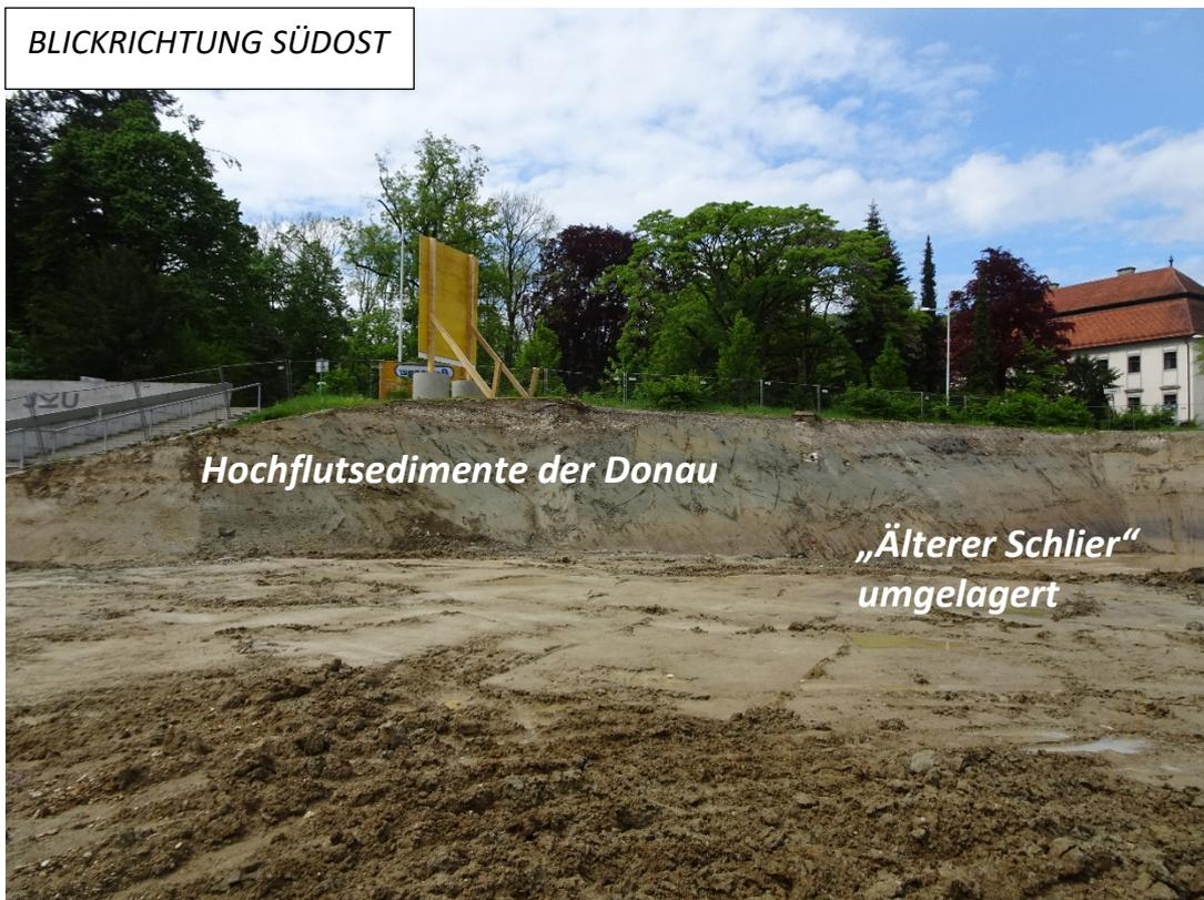
Abb. 2.2.1.9.: Baustellengelände der Johannes-Kepler-Universität in Linz; Hanganschnitt an der Südseite; gekennzeichnet durch schokobraunen „Älteren Schlier“ an der Basis und blau-grauen Hochflutsedimenten der Donau im Hangenden (Foto: F. Hofmayer).
