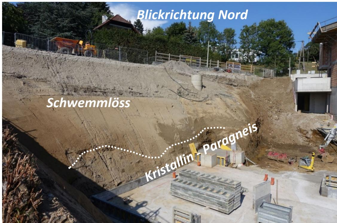
Abb. 2.1.3.17.: Baugrube am Reisingerweg in Linz, Pöstlingberg: an der Basis der Baugrube stark verwitterte, geschieferte Paragneise, die an der Ostseite bis zur Geländeoberkante reichen; im Hangenden Schwemmlöss erkennbar (Foto: M. Peresson).
