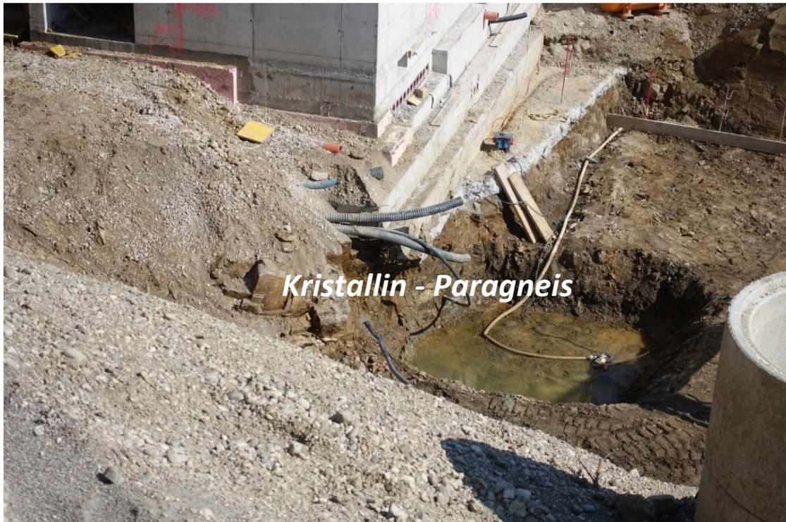
Abb. 2.1.3.15.: Baugrube am Reisingerweg in Linz, Pöstlingberg: an der Basis der Baugrube stark verwitterte, geschieferte Paragneise erkennbar (Foto: M. Peresson).
