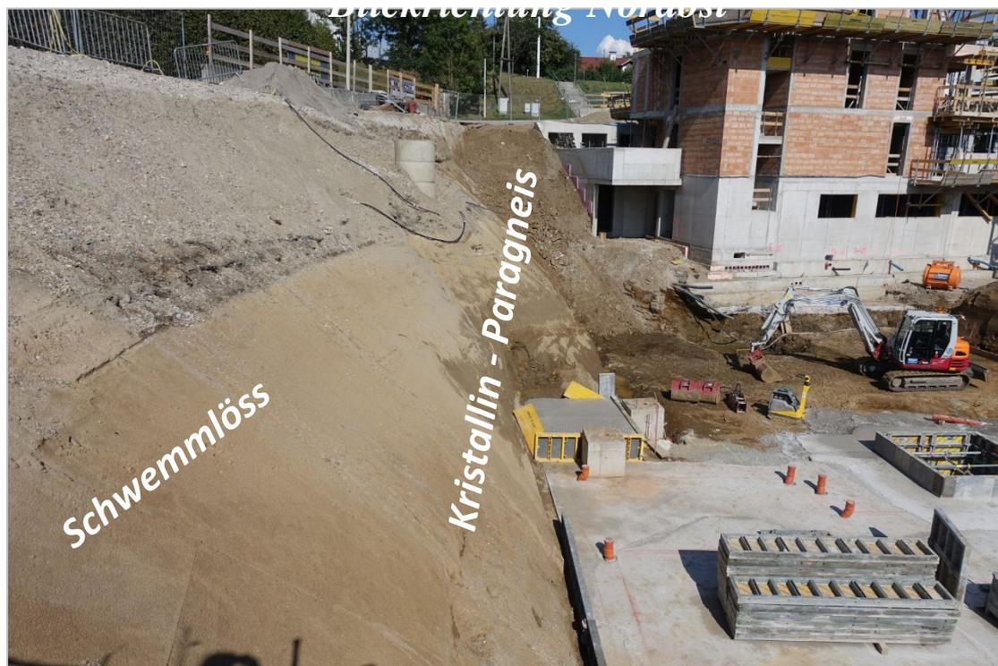
Abb. 2.1.3.16.: Baugrube am Reisingerweg in Linz, Pöstlingberg: an der Basis der Baugrube stark verwitterte, geschieferte Paragneise, die an der Ostseite bis zur Geländeoberkante reichen; im Hangenden Schwemmlöss erkennbar (Foto: M. Peresson).
