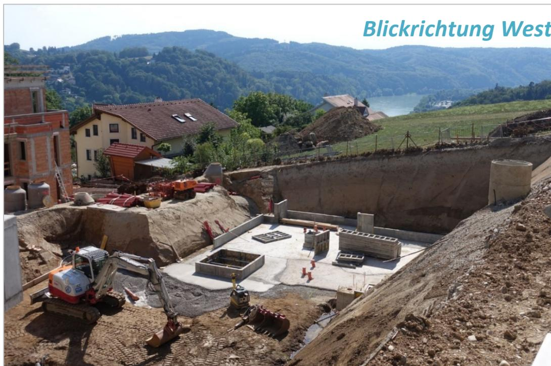
Abb. 2.1.3.10.: Baugrube am Reisingerweg in Linz, Pöstlingberg: an der West- und Südseite sind über geringmächtigem Kristallin ockerbraune Deckschichten zu erkennen (Foto: M. Peresson).
